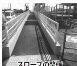
スロープの整備
